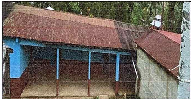
FOTO 6: ESTRUCTURA DE MADERA Y LÁMINAS EN PÉSIMAS CONDICIONES
