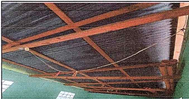
FOTO 5: ESTRUCTURA DE MADERA MUY DETERIORADA
